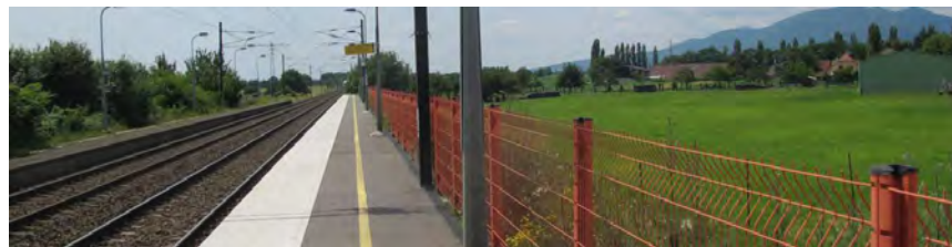
Parcelle de pré de fauche, amendée et de faible diversité floristique, jouxtant la gare de Raedersheim.
